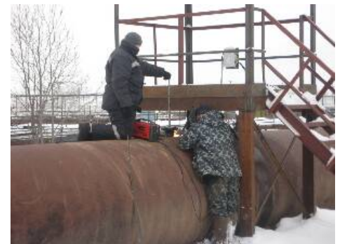
1-я операция. Приварка фланцевого патрубка
