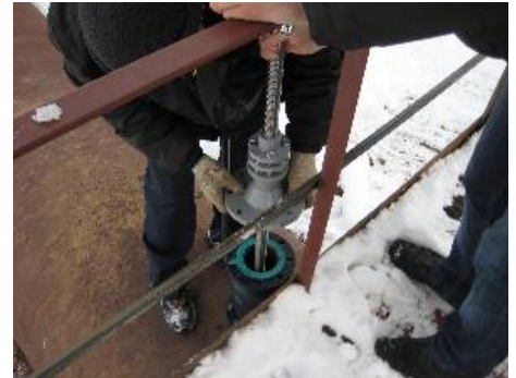
4-я операция. Установка расходомера на закрытый шаровый кран
