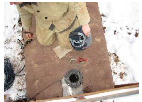
Отверстие вырезано, теперь можно устанавливать шаровый кран
