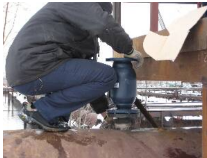
3-я операция. Установка закрытого шарового крана и возобновление потока в трубопроводе
