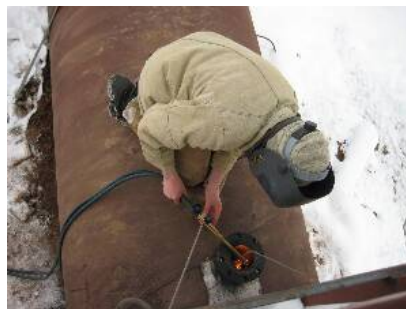
2-я операция. Останов потока и вырезка отверстия в трубопроводе
