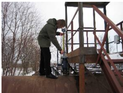
5-я операция. Открытие шарового крана и погружение зонда расходомера на требуемую глубину
