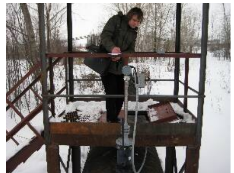
6-я операция. Электрическое подключение расходомера
