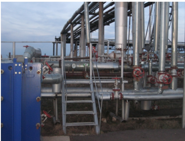
Успешно реализованный проект по организации учета тепла на нефтеперерабатывающей установке.
