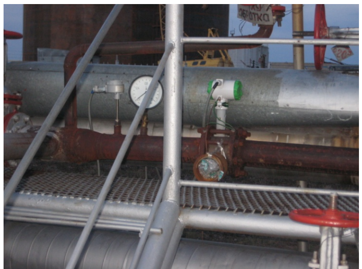
Закрепленная технологическая вставка делает обслуживание прибора максимально удобным и позволяет сократить время простоя трубопровода
