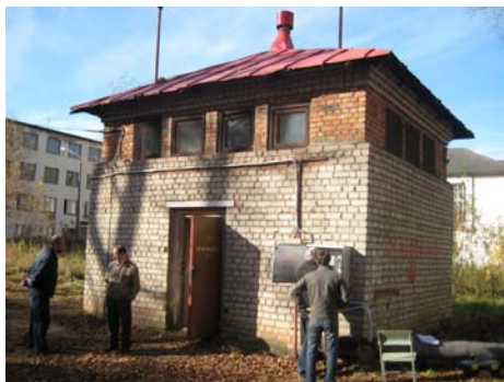
Монтаж блока питания ЭМИС-БРИЗ 90 и вычислителя СПГ в щитке.
