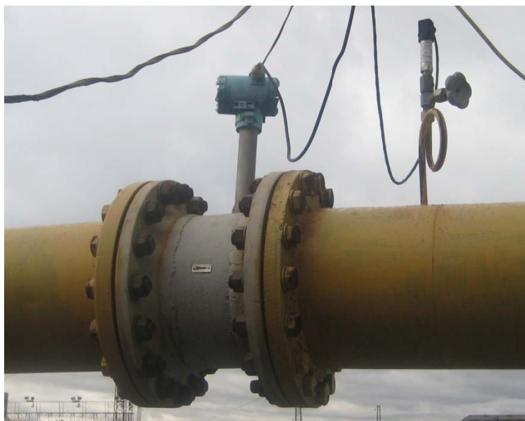
Вихревой расходомер ЭМИС-ВИХРЬ 200 диаметром 300 мм, в одном из узлов учета природного газа
